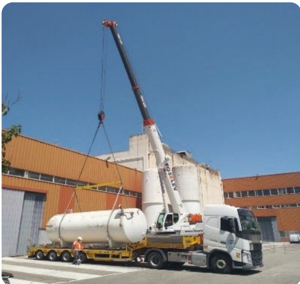
Figure 4 : chargement du réservoir d'hélium liquide de 20 000 litres pour sa réparation en usine
