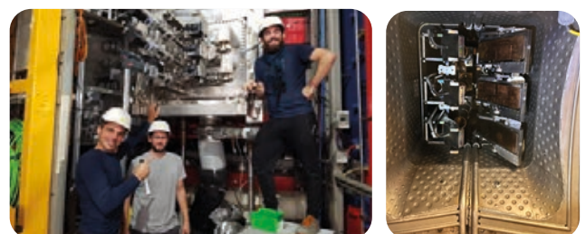
Figure 3 : Antenne ECRH montée dans le tokamak avec ses trois voies
