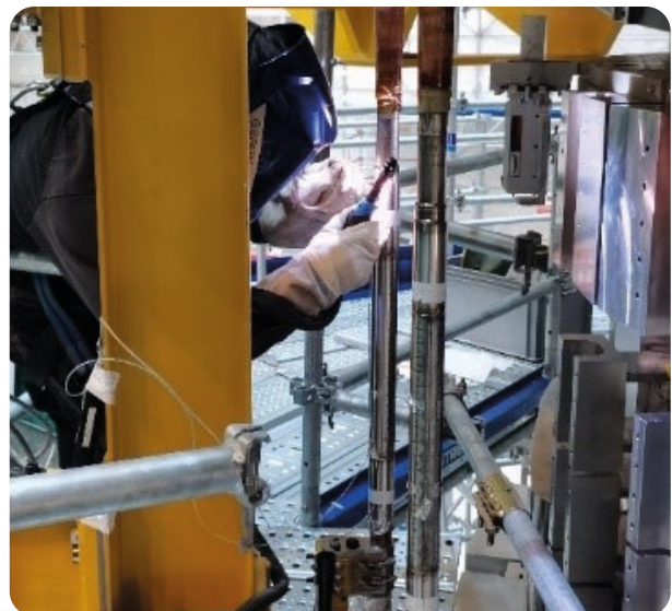
Figure 4: Assemblage sur site ITER du premier joint coaxial
