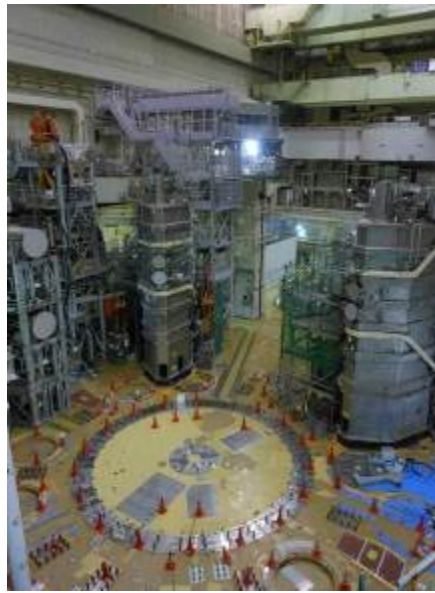
Vue du hall tokamak à Naka après la déconstruction de JT-60U
