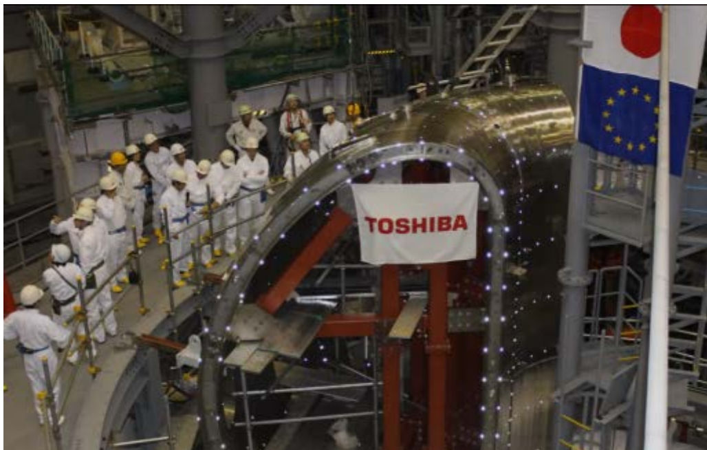
Pose des deux premiers secteurs de l'enceinte à vide de JT-60SA, juin 2014
