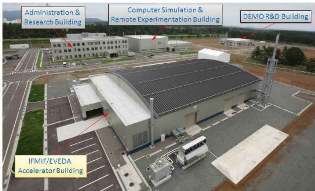
Bâtiments Ifmif/Eveda et Iferc sur le site de Rokkasho
