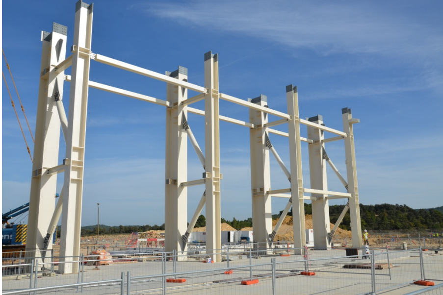
© Agence Iter France. Premiers piliers du hall d'assemblage.
