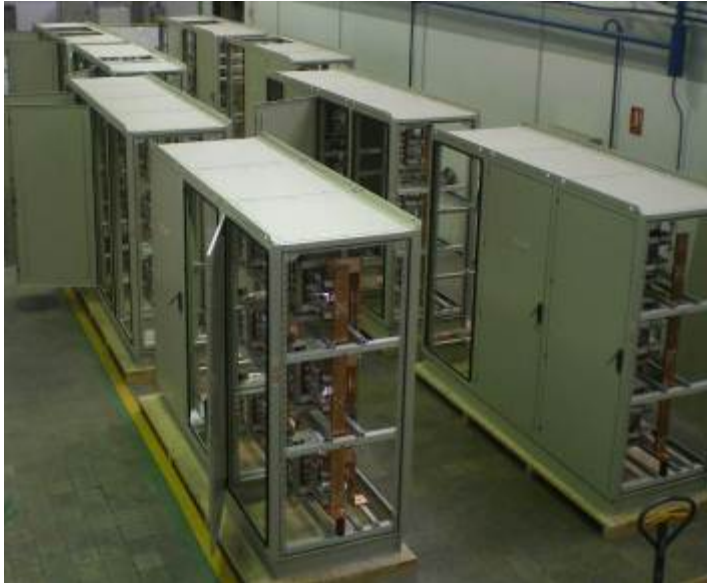
Armoires de puissance pour deux alimentations électriques en cours d'assemblage par Jema en Espagne, septembre 2014
